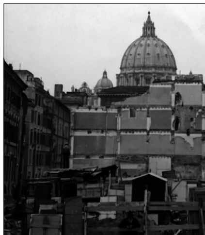
Una fase dei lavori per la creazione di via della Conciliazione
