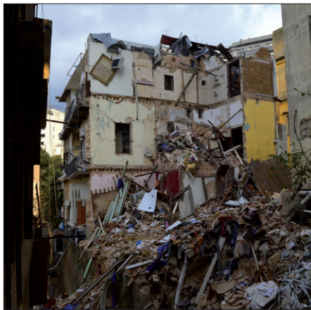
I palazzi distrutti dall'esplosione a Beirut (Epa)
